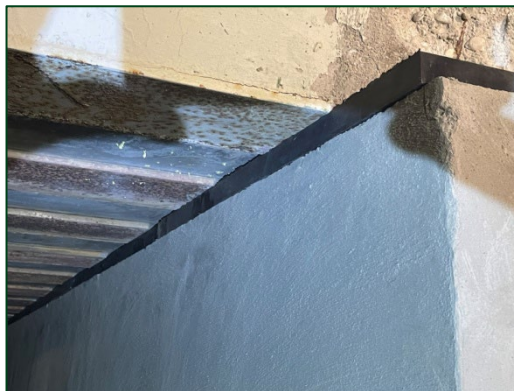
SUPPORTS DE PONT
